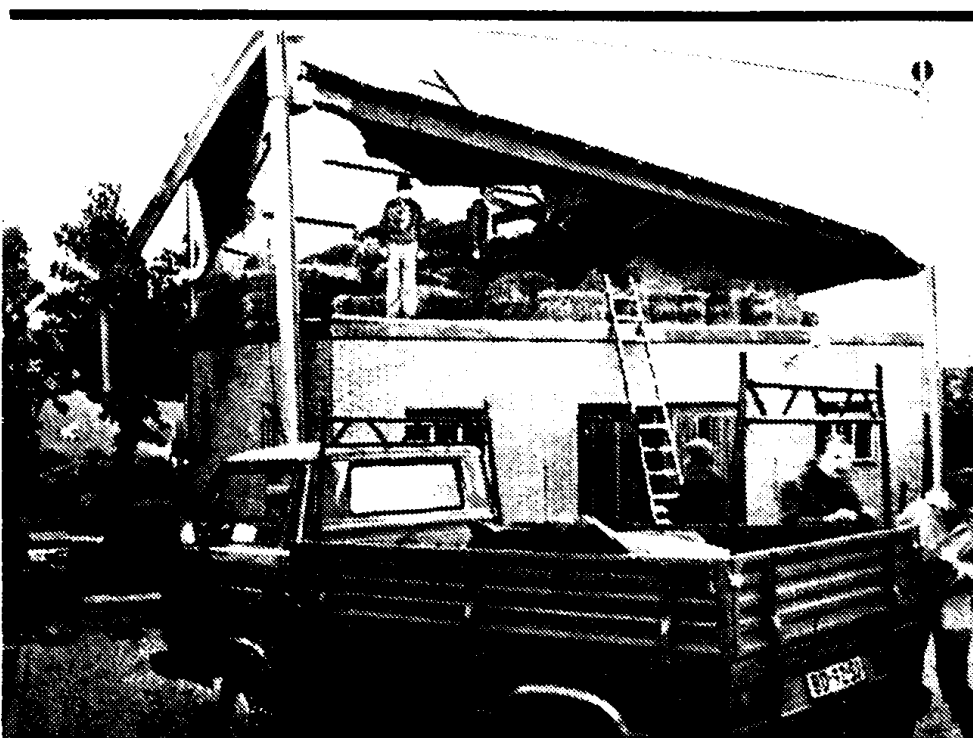
Het dak van de hooischuur van boer Klein Hesselink in Rotterdam werd als een veertje opgetild en weer neergekwakt.
